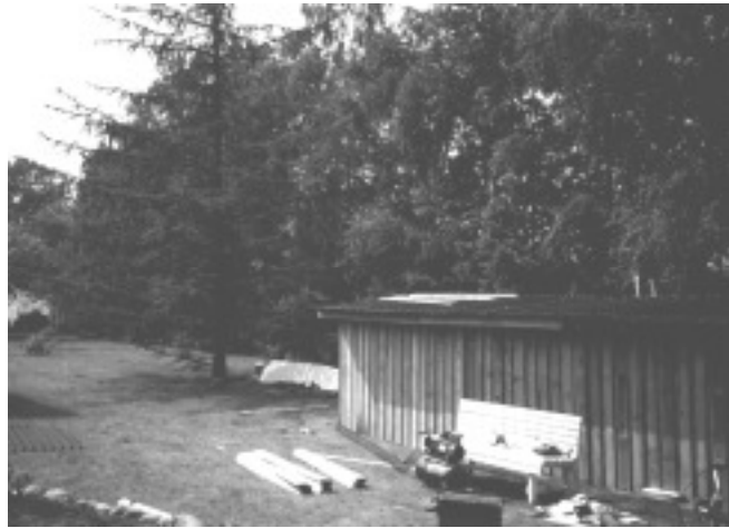
Udhus under konstruktion
